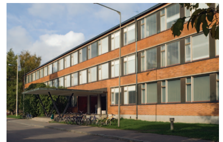
Kuvassa rakennustekniikan laitoksen talo Espoon Otaniemessä, johon paloprofessori sijoitetaan.
