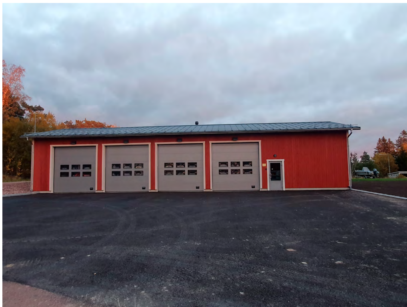
Bild 7. Denna brandstation som byggts på Åland används av Jomala FBK rf. Garaget är cirka 175 m 2 stort. Jomala FBK rf fick 51 881 euro i understöd för projektet. Bild: Jomala FBK/Brandskyddsfonden.
