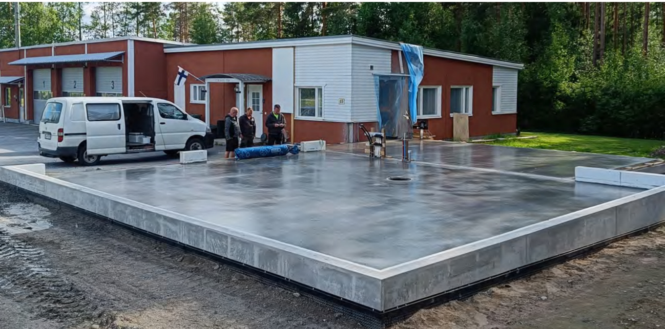
Bild 1. Våren 2025 beviljades Terjärv Frivilliga Brandkår r.f. 84 014 euro i understöd för en tillbyggnad till brandstationen. Grunden började gjutas kort efter understödsbeslutet. Projektet har även följts i Yles dokumentärserie Bränder & Jäkelskap, som berättar om vardagen i Terjärv FBK. Bild: Mats Lindh / Terjärv Frivilliga Brandkår r.f.
