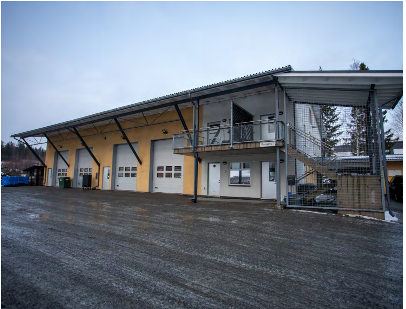
Bild 1. Kuopion Vapaaehtoinen Palokunta r.y. köpte den 12 november 2024 en tidigare industrihall och lät renovera den så att de kan användas som brandstation. I den nya brandstationen har den frivilliga brandkårens alla fyra fordon en plats med egen taksjutport. Brandskyddsfonden beviljade 350 000 euro i understöd (maximalt understöd) för byggnadsprojektet. Bild: Sami Kejonen.
