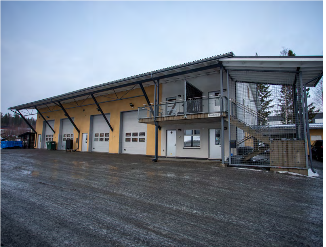
Kuva 1. Kuopion Vapaaehtoinen Palokunta r.y. osti 12.11.2024 itselleen teollisuushallina toimineen rakennuksen, joka remontoitiin pelastusase- makäyttöön. Uudella asemapaikalla jokaiselle VPK:n käytössä olevalle neljälle ajoneuvolle on oma nosto-ovi. Palosuojelurahasto on myöntänyt rakennushankkeelle avustusta 350 000 euroa (enimmäisavustus). Kuva: Sami Kejonen.
