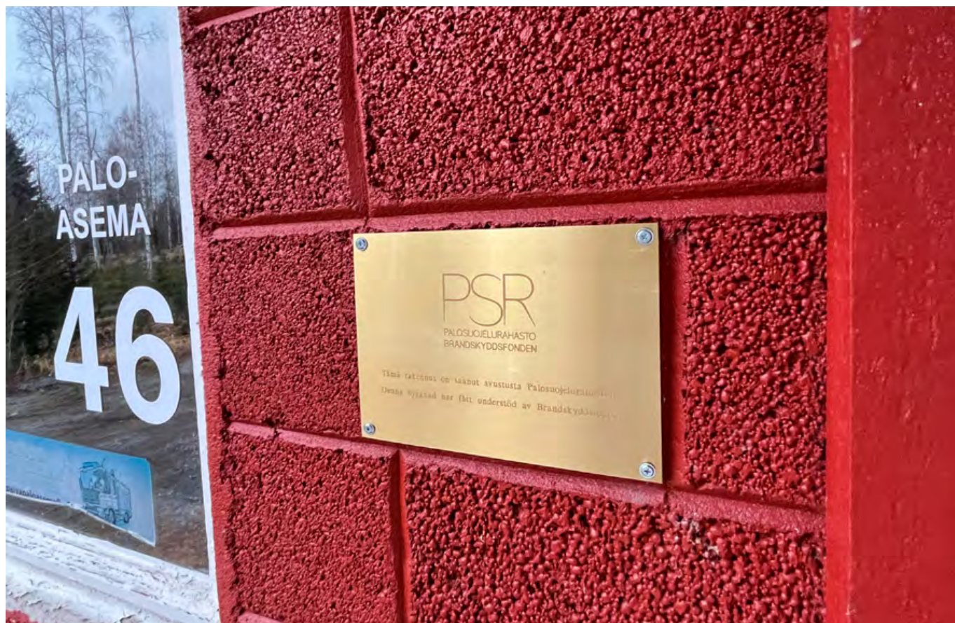
Kuva 15. Kaikkiin Palosuojelurahaston avustamiin rakennuksiin kiinnitetään messinkinen rakennuslaatta, jossa lukee "Tämä rakennus on saanut avustusta Palosuojelurahastolta". Kaikkien hakijoiden tulee tilityksen yhteydessä toimittaa Palosuojelurahastoon kuva rakennuksen seinällä olevasta rakennuslaatasta. Kuva: Menosten vapaaehtoinen palokunta ry
