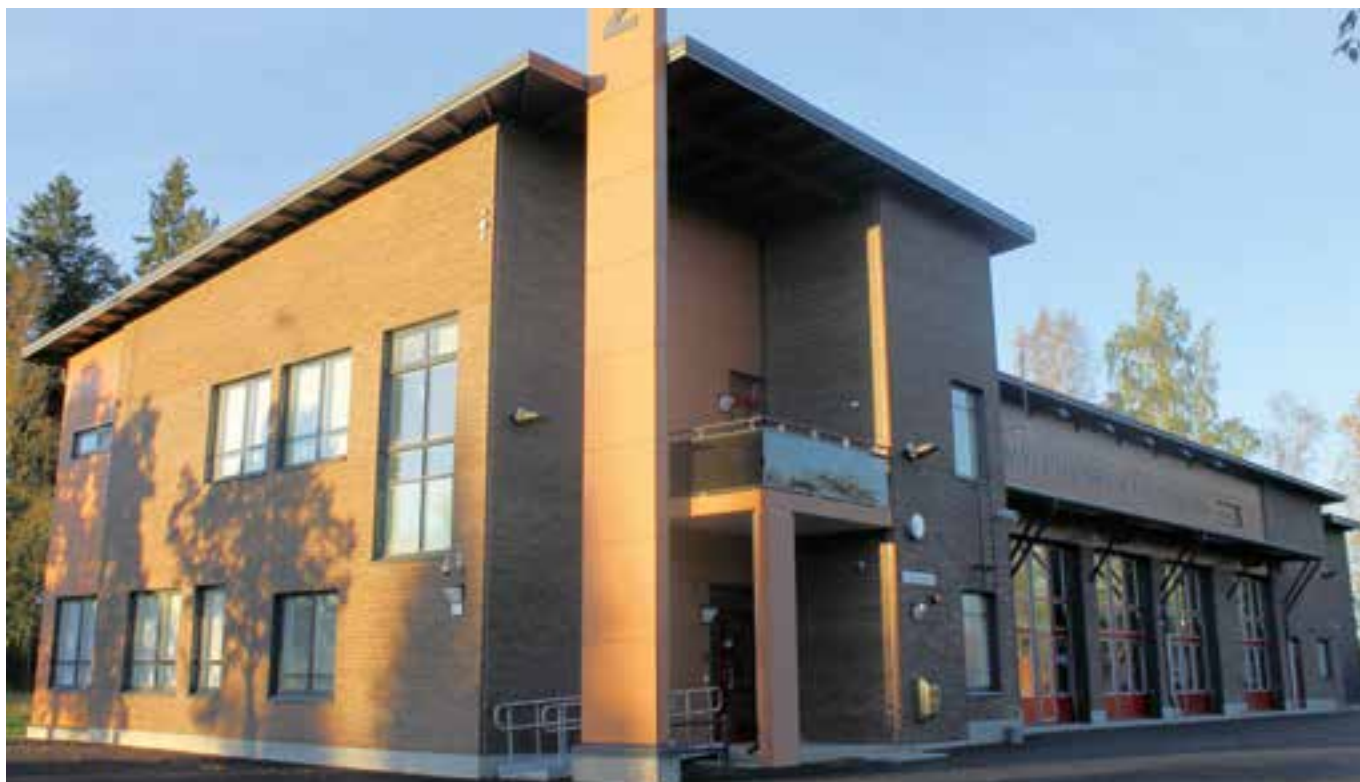
Kuva 2. Kouvolan kaupungille myönnettiin Myllykosken paloasema-hankkeeseen yhteensä 225 000 euron avustus vuonna 2015. Rakennukseen on sijoitettu kolme autopaikkaa sammutus-, säiliö- ja miehistöautolle. Paloasemalla on lisäksi tilat kahdelle peräkärlylle, veneelle ja ambulanssille. Myllykosken paloasema on kerrosalaltaan 803 m 2 :n suuruinen, josta aseman autohalli, työtila ja varasto ym. tilat ovat yhteensä 550 m 2 . Asemalla on lisäksi toimisto-, oleskelu- ja muita oheistiloja yhteensä 253 m 2 . Myllykosken paloasema otettiin käyttöön 20.8.2016. Kuva: Juha Tiitinen.
