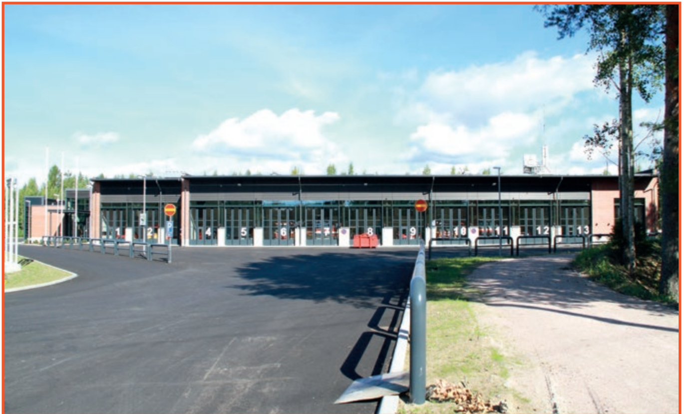
Heinolan uuden pelastusaseman vihkiäisiä vietettiin 25.10.2013. Pelastusasema on 2-kerroksinen ja bruttoalaltaan 3 044m 2 . Lisäksi samalla tontilla on 551m 2 :n varistorakennus. Rakennuksessa toimii vakinainen palokunta sekä puolivakinainen palokunta, jolle tehtiin autohallipaikkojen lisäksi omat sauna-, sosiaali- ja toimistotilat. Kuva: Tuomas Rantala
